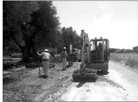
Muro Tenente. Scavi nei pressi del Parco
