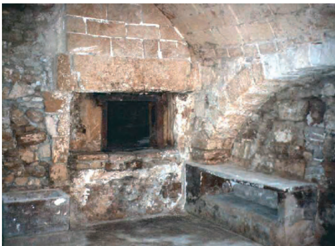
Via Santacesaria - frantoio ipogeo, il forno
