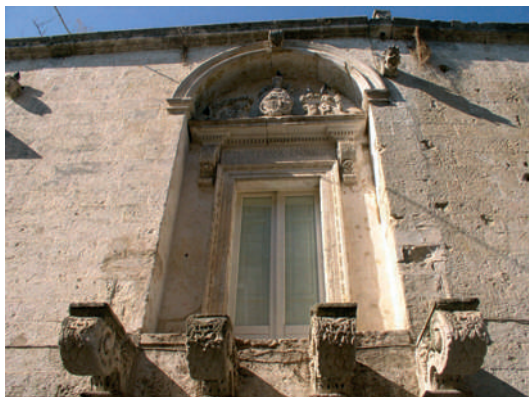
Via E. Santacesaria - Palazzo Guarini, particolare del loggiato
