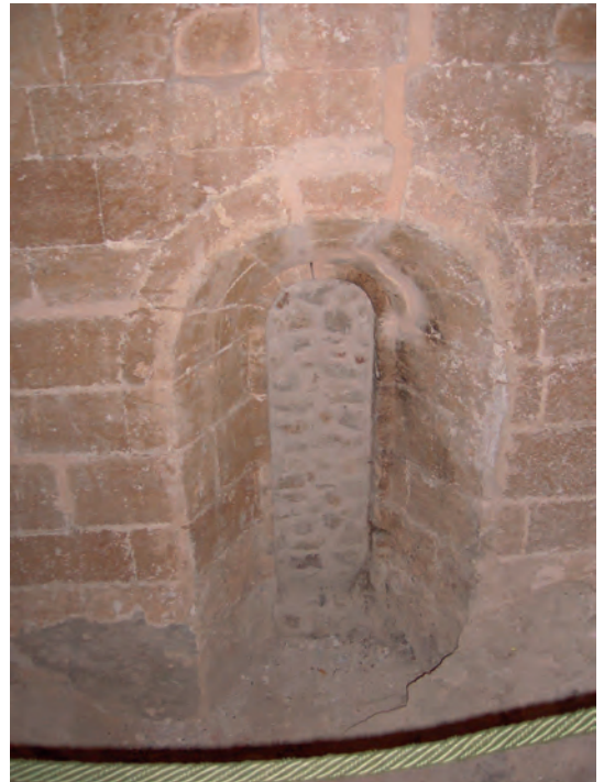
Monofora del piano ammezzato
