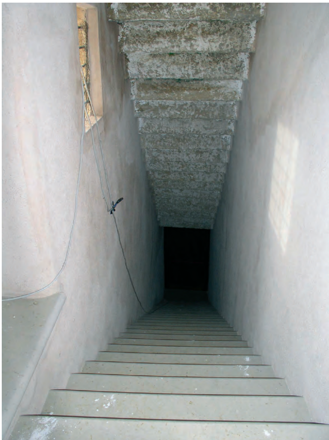
Il gajfo - scala segreta che metteva in comunicazione il piano nobile con le cucine al piano terreno
