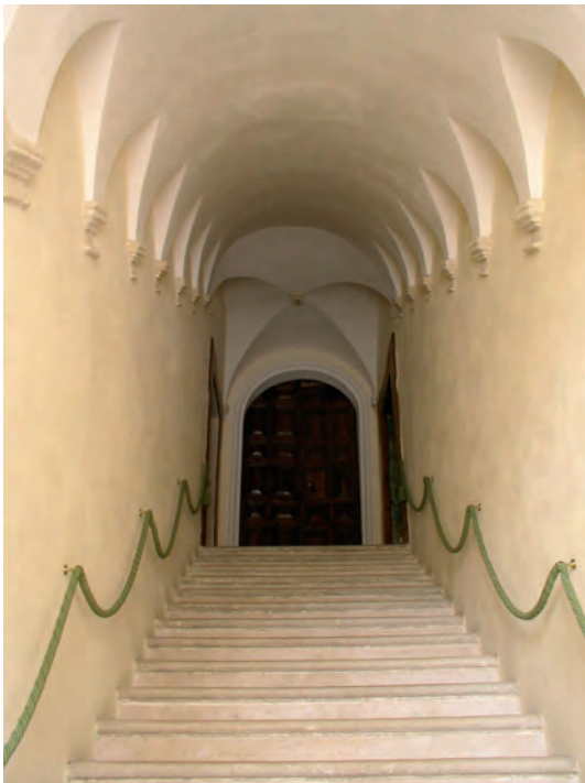
Scale di accesso al piano superiore
