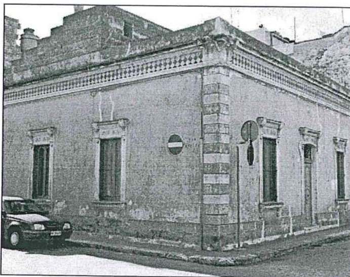
Il prospetto di casa Antonacci all'angolo tra via Puccini e via Volta
