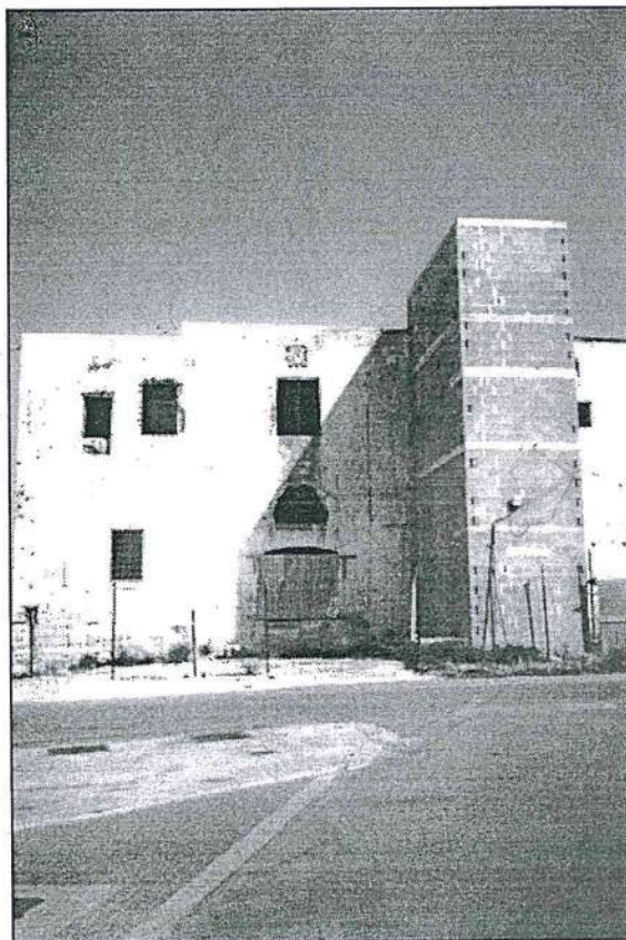
Il vano scala addossato alla facciata della Chiesa. Simbolo di una cattiva politica dei beni culturali che è stato abbattuto per primo durante i lavori di restauro
