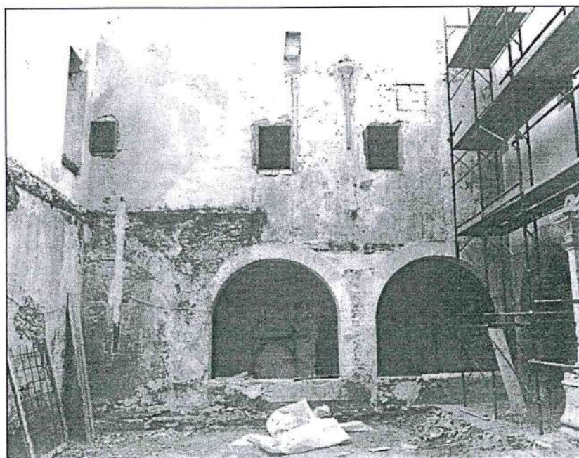
Lavori di ripristino del chiostro cappuccino
